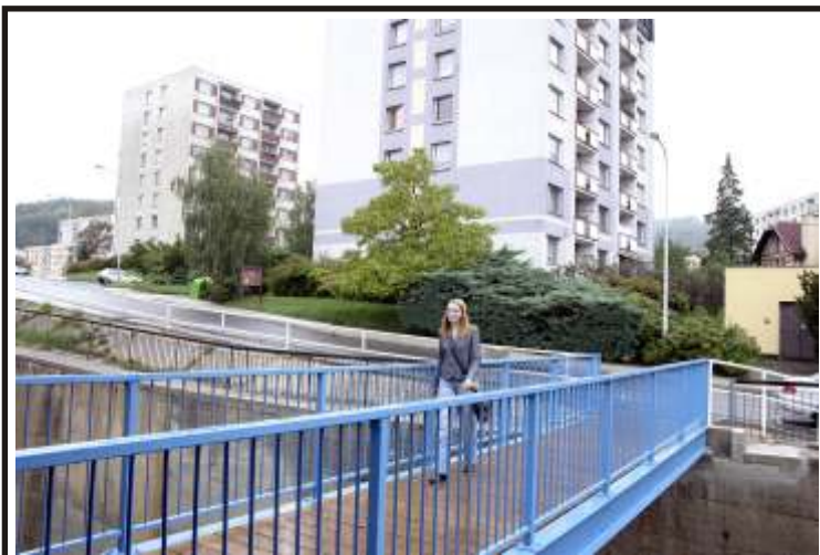
Novou lávku používají od začátku měsíce obyvatelé děčínské části Bynov. Téměř dvanáct metrů dlouhé přemostění u obchodního centra Dukla jim zkrátí cestu, a navíc je bezbariérové. Ocelová konstrukce má dřevěnou podlahu. Celkem celá stavba stála více než 930 000 korun. Dělníci ji začali montovat v srpnu letošního roku nejprve v dílně, v září pracovali už přímo na místě. Samotné obchodní centrum, jehož některé části nejsou v nejlepší stavu, rekonstrukce zatím nečeká. Problémem jsou nevyjasněné majetkové vztahy k areálu.
